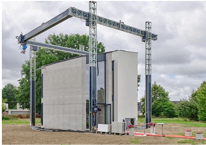
Imatge 11: Impressora 3D per construir estructures. Extreta de Impresora-3D-para-casas.jpg
